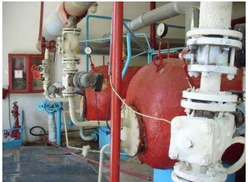
Рис. 2 Тепловой узел (Республика Беларусь , г. Минск)
